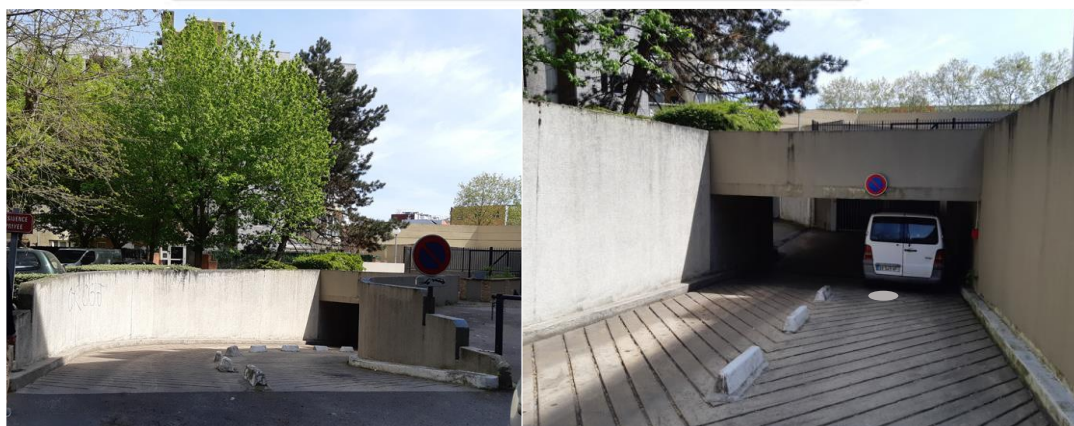
Rampe d'accès, commune aux copropriétés et au parking propre à Seqens
